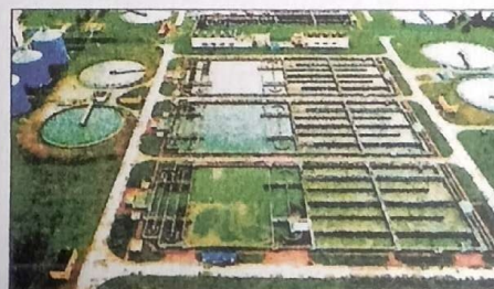
บ่อที่ใช้ในระบบบำบัดน้ำเสีย
